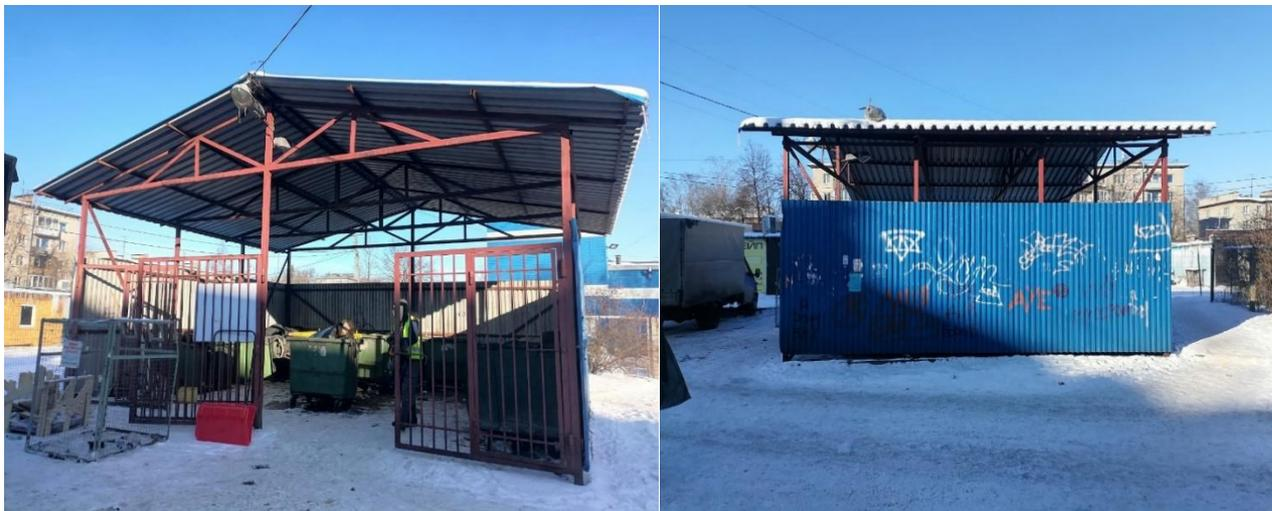
Контейнерная площадка оборудована твёрдым (асфальтовое, бетонное) покрытием с уклоном для отведения талых и дождевых сточных вод, а также ограждением с четырёх сторон высотой не менее 1 метра, обеспечивающим предупреждение распространения отходов за пределы контейнерной площадки.
