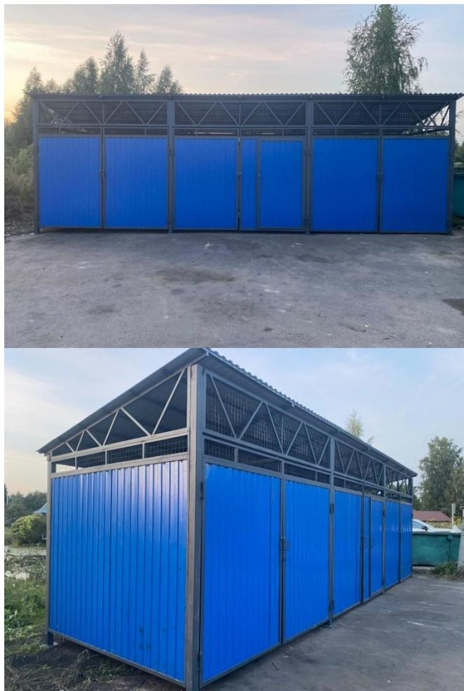
Контейнерная площадка оборудована твёрдым (асфальтовое, бетонное) покрытием с уклоном для отведения талых и дождевых сточных вод, ограждением с четырёх сторон высотой не менее 1 метра, обеспечивающим предупреждение распространения отходов за пределы контейнерной площадки.
