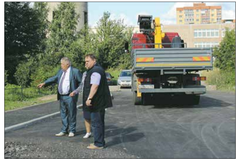
Депутаты inspectируют ремонт ул. Полевой
