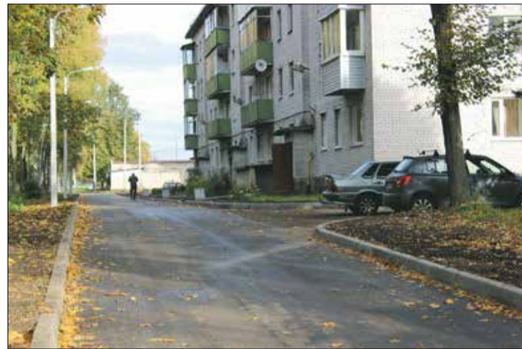
Дорога на ул. Муравицкого в дер. Капитолово после ремонта
